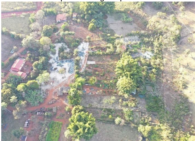
Figura 09: Área de intervenção, construção do dissipador de águas pluviais.
